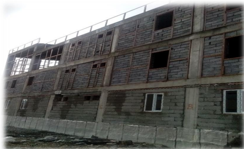
ساختمان ستاد شبکه هشترود
